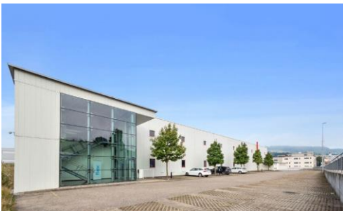
Küsnacht (SZ), Zugerstrasse 55
