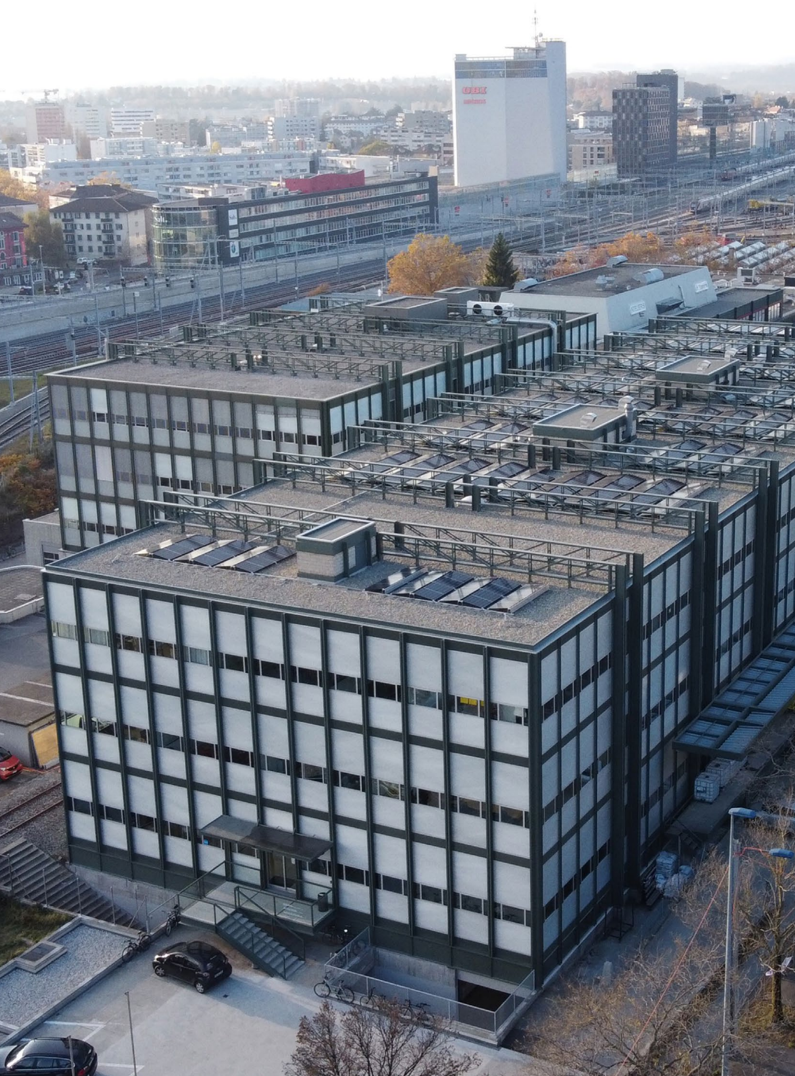
Renens, Rue de Lausanne 64 (VD) avec des panneaux solaires sur la toiture.
